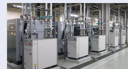
エア圧力の低減によりエネルギー消費量を削減した生産工程
