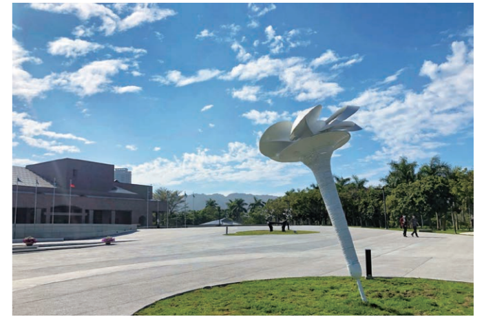
Kaohsiung Museum of Art, the entire building © 高雄市立美術館
